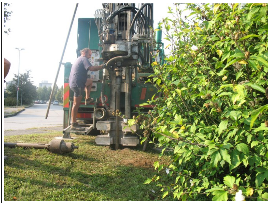
Sondaggio S1: fase d'avanzamento della perforazione
