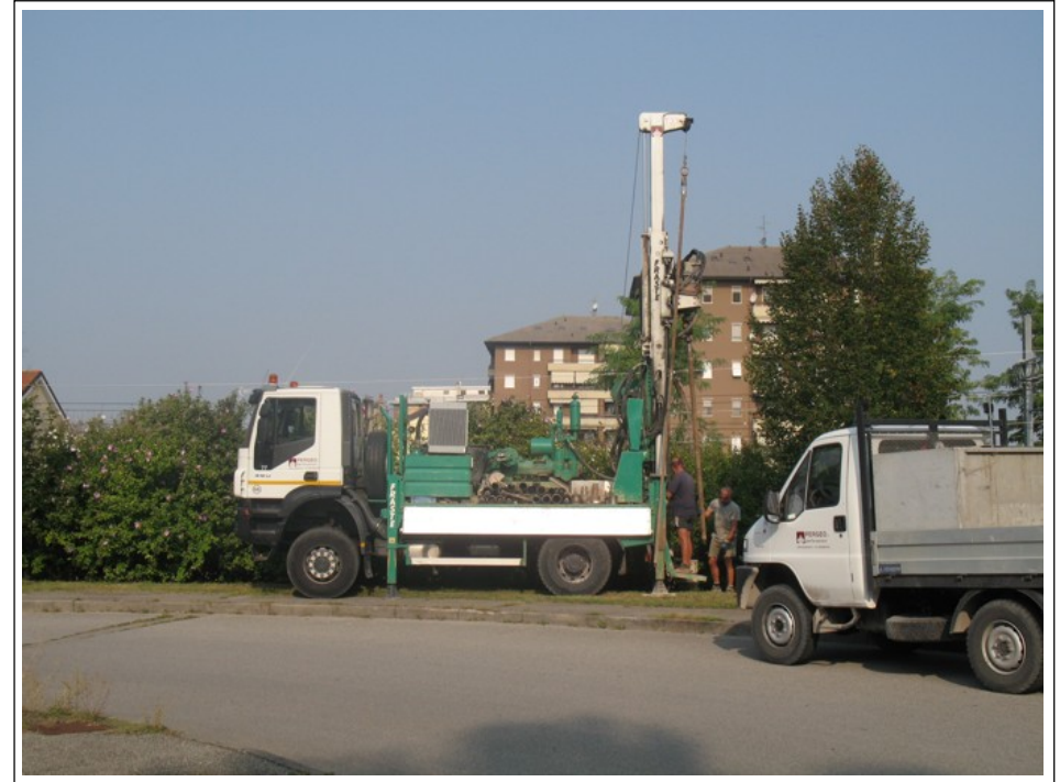
Posizione del sondaggio stratigrafico S1; vista verso Ovest
