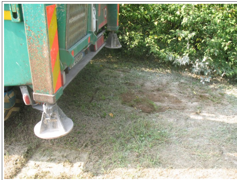
Sondaggio S1: fine della perforazione e ripristino delle condizioni iniziali dell'area prativa
