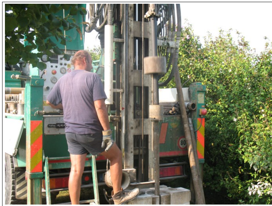
Sondaggio S1: fase d'avanzamento della prova in foro SPT in cui si nota la caduta del maglio di battuta
