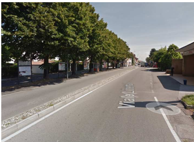
Figura 5 – Foto tratto 'B' - direzione Ovest
