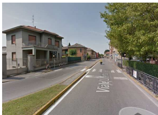
Figura 3 – Foto tratto 'A' - direzione Est
