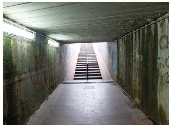
Le foto evidenziano il cattivo stato manutentivo del sottopasso ed i principali fenomeni degenerativi in atto.
