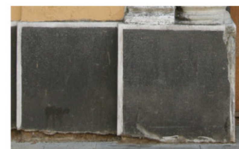
Particolare della zoccolatura realizzata con malta di cemento, ricoperta con intonachino plastico tipo "terranova"
