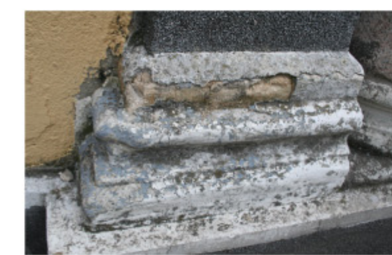
Particolare decorativo, realizzato con pietra e mattoni ricoperta d'innnumerevoli strati di intonachino e pitturazioni successive.
