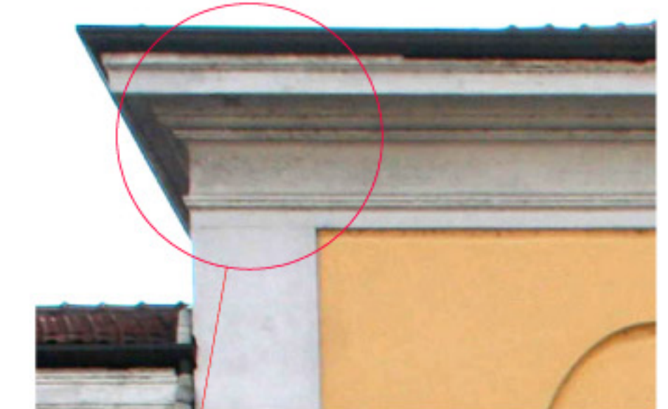
Particolare della gronda e delle modanature orizzontali, realizzate con struttura portante in lastre di pietra e mattoni, il tutto modellato e rifinito in opera con malta, ricoperta d'innnumerevoli strati di pitturazioni successive.
