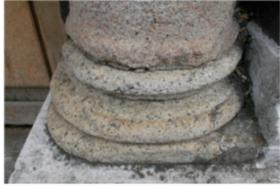
Particolare del basamento e colonna in granito. Si evidenzia la mancanza di porzioni, presenza di stuccature improprie e degradate, deposito superficiale di polveri e sporco generalizzato, con macchie di ruggine, patine biologiche e alterazioni cromatiche.
