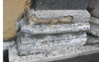
Particolare decorativo, realizzato con pietra e mattoni ricoperta da innumerevoli strati d'intonachino e pitturazioni successive. Questi strati risultano anche degradati con fenomeni di disgregazione e distacchi di porzioni dello strato sottostante.
