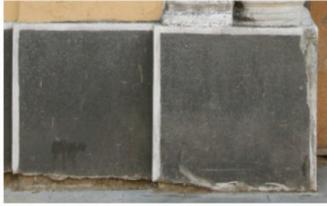
Particolare della zoccolatura realizzata con malta cementizia ricoperta con intonachino plastico tipo "terranova". Tale intonachino risulta improprio e accentua il degrado.
