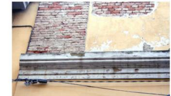
Particolare delle lesene orizzontali realizzate con mattoni e modellate in opera con malta di cemento, ricoperta d'innumerabili strati di pitture successive. Come per gli altri elementi, il ristagno d'acqua sul cornicione, causa dilavamento e attacco biologico, degrado per gelo / disgelo e chimico dovuto agli agenti atmosferici, hanno portato alla fessurazione dell'intonaco permettendo all'acqua di percolare all'interno, raggiungendo e causando un inizio di degrado anche allo strato di mattoni.
