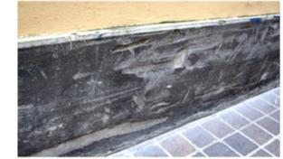
Particolare della zoccolatura realizzata con malta di cemento, ricoperta con intonachino plastico tipo "terranova" molto degradato. La presenza massiccia di cemento favorisce anche la migrazione dei sali e la cristallizzazione interna con la creazione di distacchi nell'intonaco superiore.
