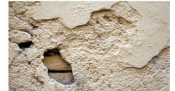
Particolare dell'intonaco realizzato con più strati sovrapposti su base di muratura in mattoni. Tutto l'intonaco risulta realizzato in più strati dovuti anche a rappezzi, rifacimenti successivi prevalentemente con malta cementizia.
