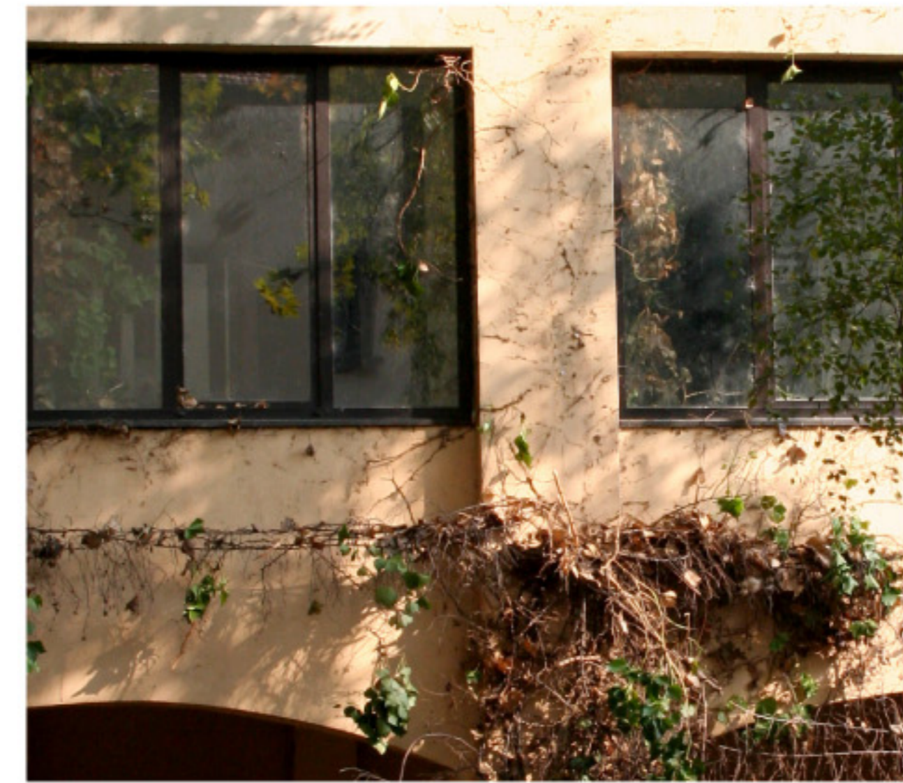
Particolare di facciata con intonaco cementizio tinteggiato e infisso in alluminio.
