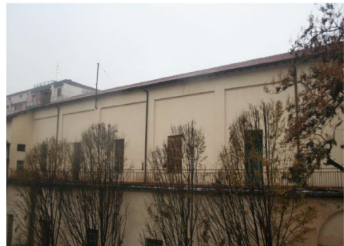
Particolare della facciata con intonaco tinteggiato e parapetto in ferro, così come porte, finestre e grate.
