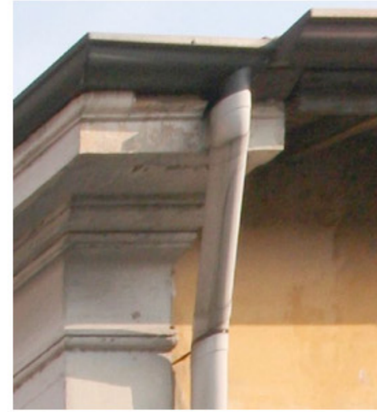
Particolare delle lesene orizzontali realizzate con mattoni e modellate in opera con malta di cemento, ricoperta da pitturazioni successive.
