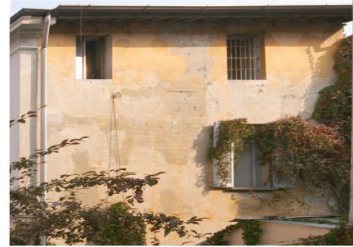
Particolare dell'intonaco realizzato con più strati sovrapposti su base di muratura in mattoni. Si notano più strati e rappezzi, mascherati da diverse tinteggiature.
