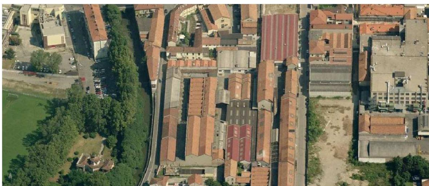
VISTA AEREA DA SUD
