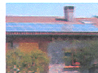
Montaggio sopra tetto
