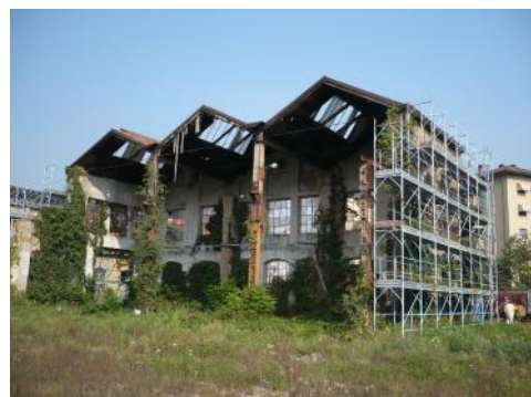
Edificio attività produttiva (F)
