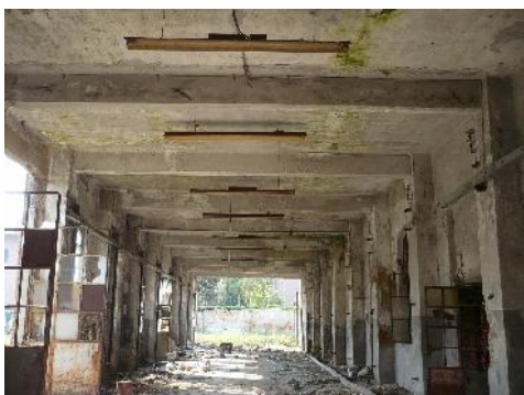
Interno edificio – uffici e laboratori (A)
