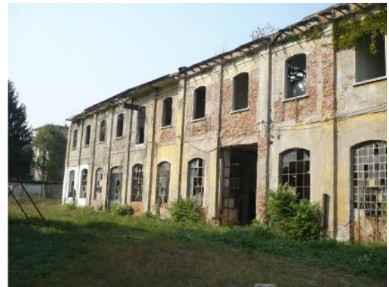
Edificio uso uffici e laboratori
