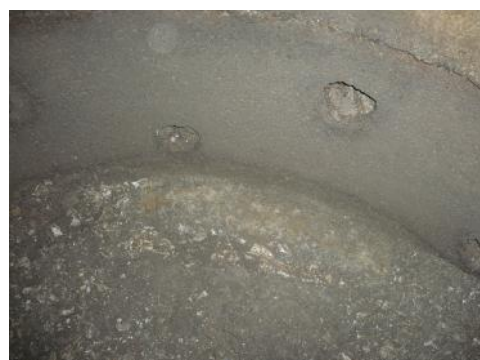
Interno pozzo perdente
