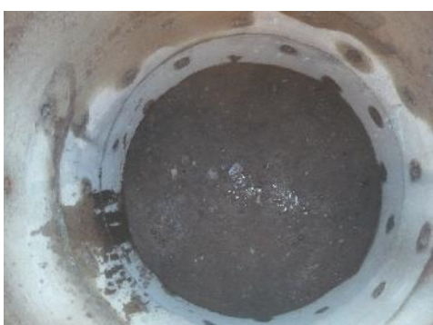
Interno pozzo perdente
