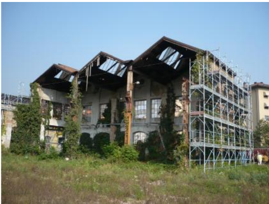
Edificio per l'attività produttiva
