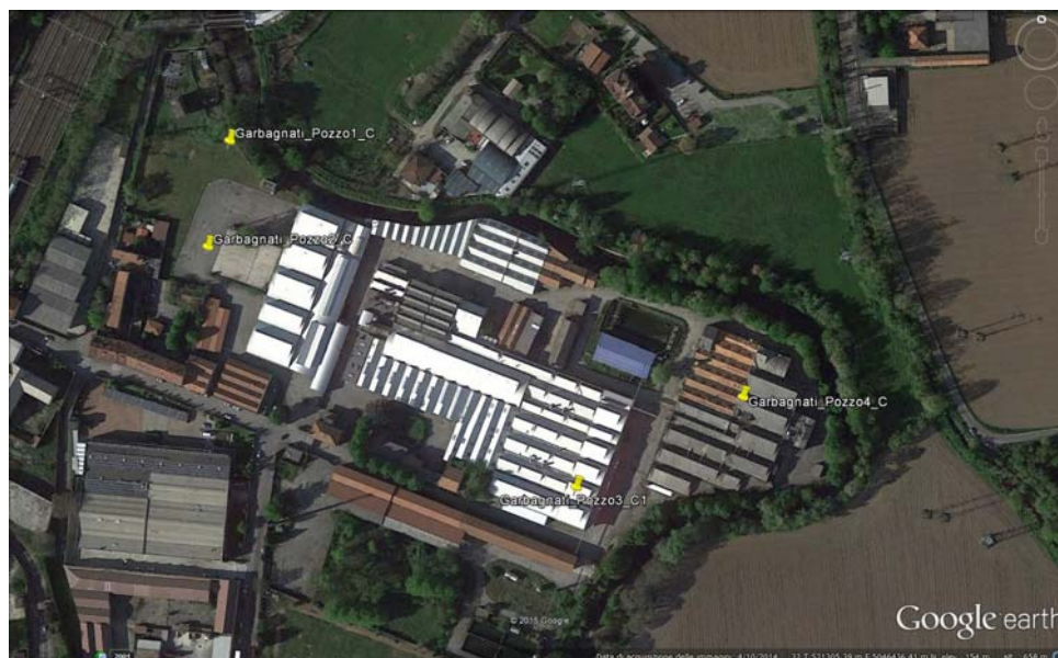
Fig. 7 - Estratto ripreso da Google Earth con l'ubicazione dei pozzi presenti nell'insediamento Giacomo Garbagnati.
