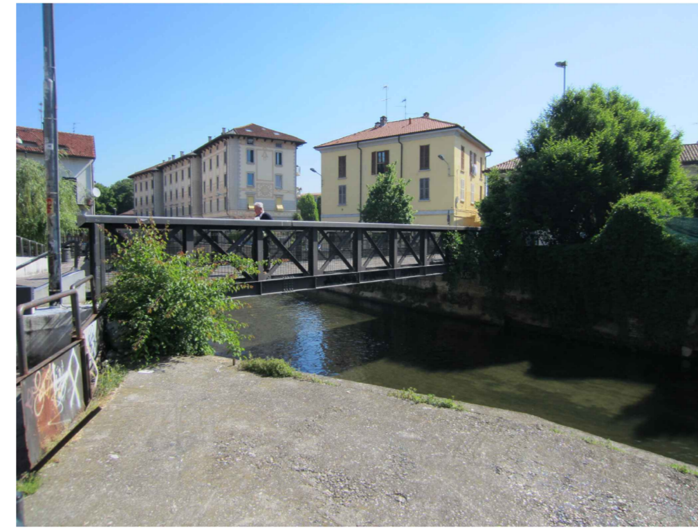
IMMAGINI DI RIFERIMENTO: PONTE DIDLO-PEDONALE DI VIA S. MADDALENA
