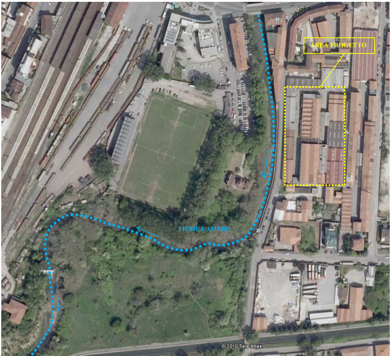
Figura 5.2 – STATO ATTUALE - Foto aerea del sito
