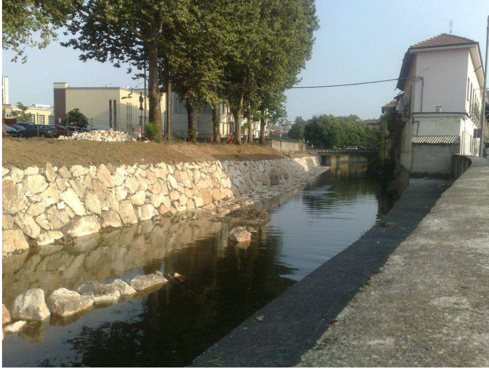
Figura 7.3.3 - Il ponte di Via Mentana visto da Via Ghilini, cioè da valle.
