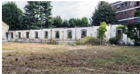
Muro residuo del vecchio capannone
