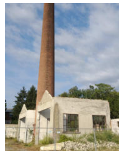
Ciminiera e resti dei capannoni annessi
