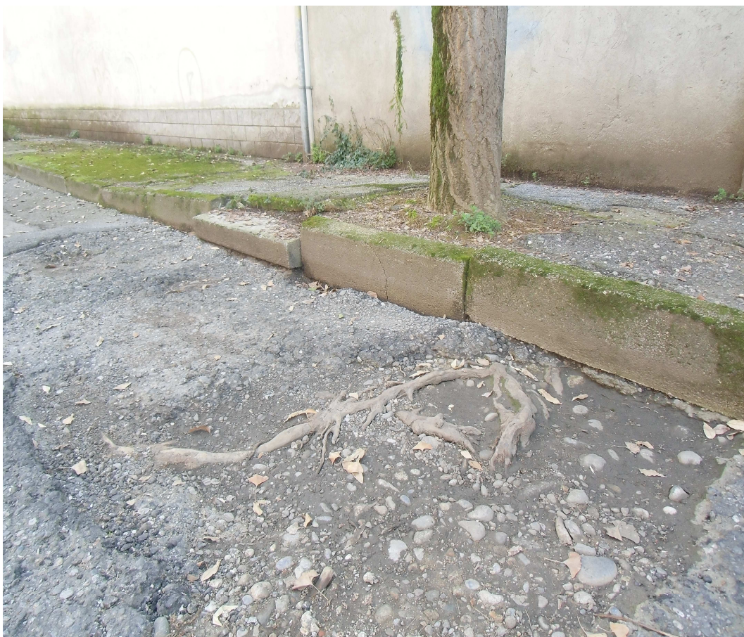
Foto n°17: la pianta di ginkgo ha sollevato le radici, portando al movimento del cordolo e dell'asfalto.
