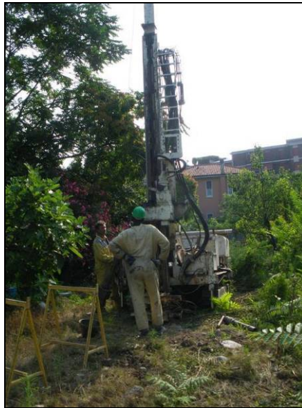
Documentazione fotografica relativa al Sondaggio S1 eseguito nell'area
