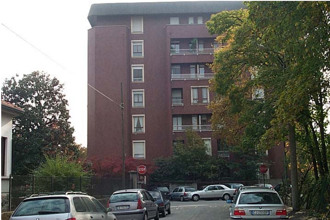
Condominio prospiciente l'area d'intervento sul lato opposto di via Cavallotti
