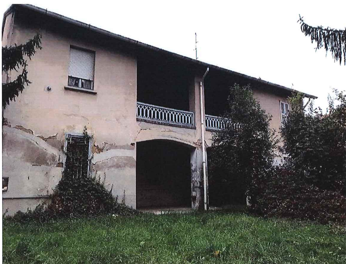
Fig. 2 – Edificio abbandonato in procinto di essere demolito
