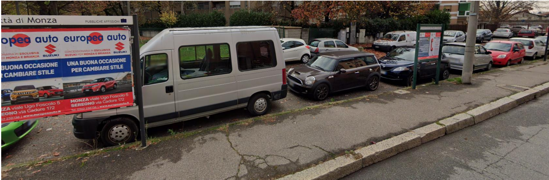
Sopra e sotto: tratto di via Manara accanto ai parcheggi del parco Schiaffino: manto di usura e segnaletica orizzontale compromessi/carenti, calibro carreggiata e marciapiedi sottodimensionati
