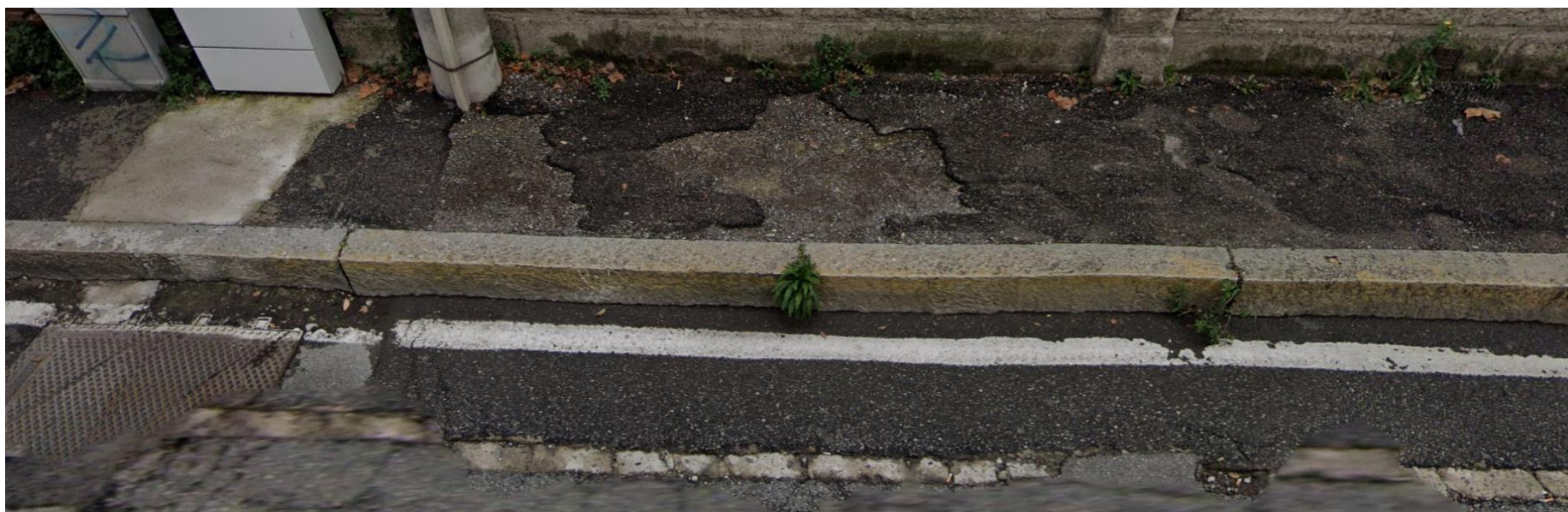
Sopra e sotto: tratto di via Manara aderente al lotto di intervento: manto di usura compromesso, calibro carreggiata e marciapiedi carenti
