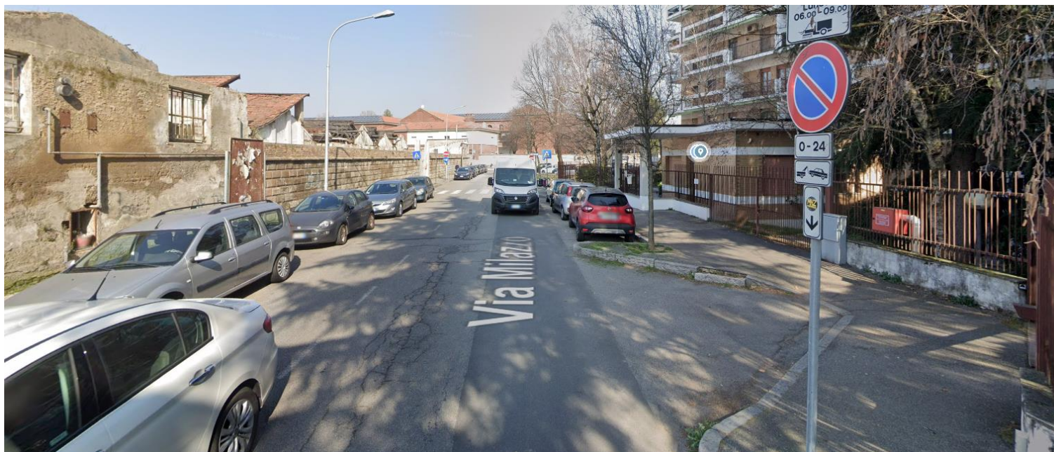
A lato, via Milazzo in direzione di via Manara e a sinistra lotto dismesso oggetto di intervento. Manto di usura compromesso.
