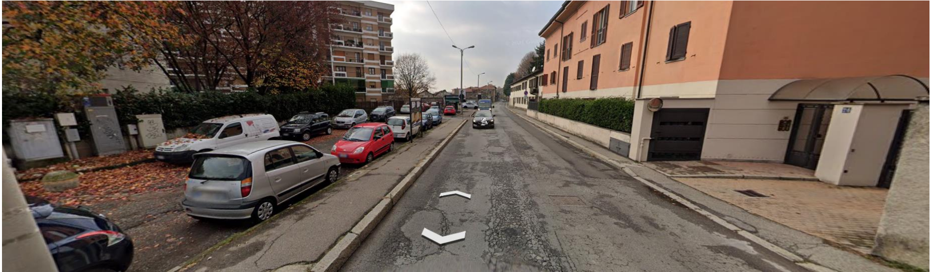
Sopra e sotto: tratto di via Manara accanto ai parcheggi del parco Schiaffino: manto di usura e segnaletica orizzontale compromessi/carenti, calibro carreggiata e marciapiedi sottodimensionati
