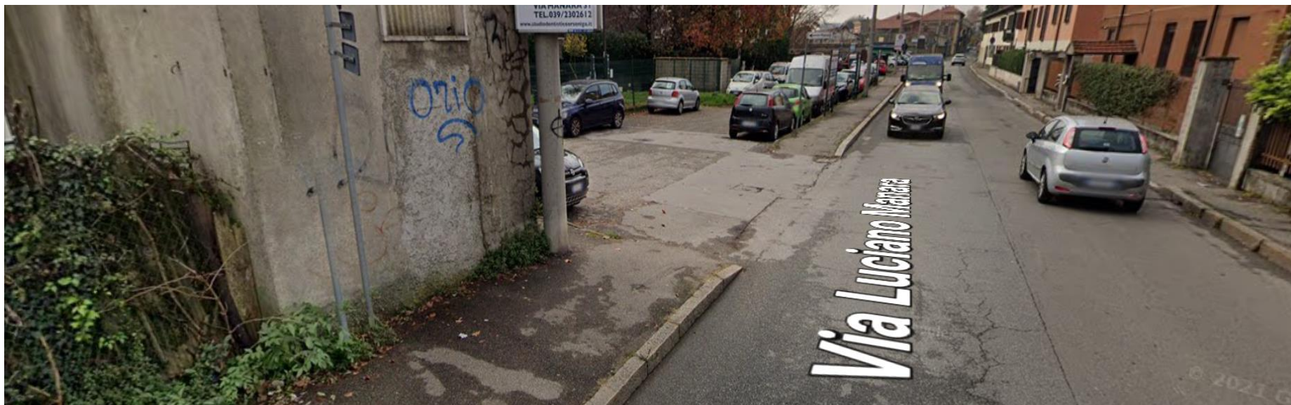
Sopra e sotto: tratto di via Manara: manto di usura e segnaletica orizzontale compromessi/carenti, calibro carreggiata e marciapiedi sottodimensionati
