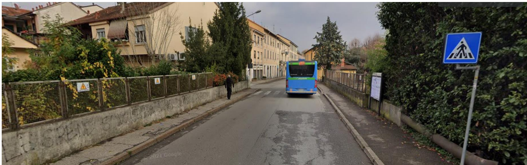
Sopra e sotto: tratto di via Manara: manto di usura e segnaletica orizzontale compromessi/carenti, calibro carreggiata e marciapiedi sottodimensionati
