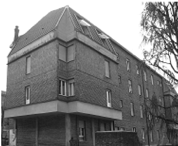
Figura 72 Edificio per abitazioni Via Toscana, 6 1958 – Arch. Fredi Drugman
