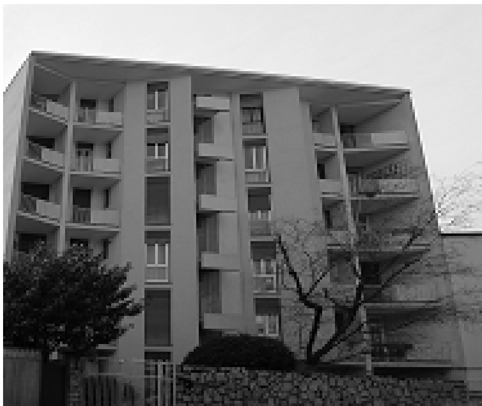
Figura 69 Edificio per abitazioni Via Massimo d'Azeglio, 11 1953 – Arch. Vittorio Faglia
