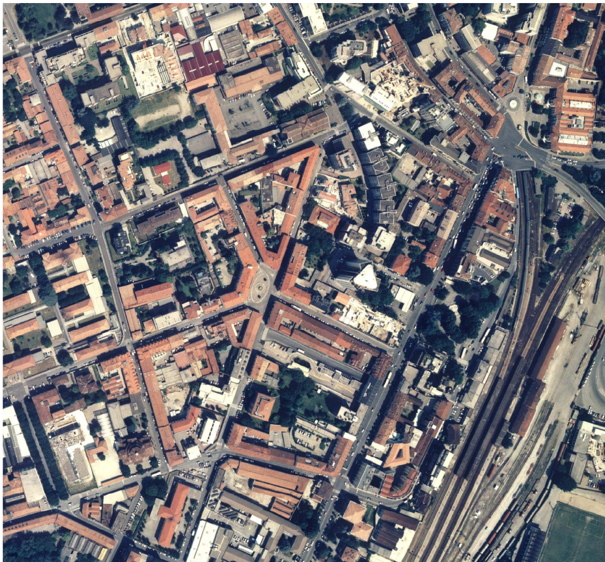
Figura 83 Foto aerea della zona tra Largo Mazzini, la Stazione Centrale e l'Ospedale Vecchio
