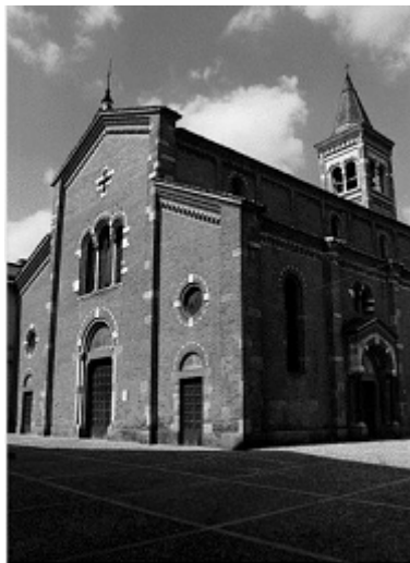
Figura 46 Chiesa e Convento Domenicano di S. Pietro Martire. La chiesa trecentesca è stata più volte rimaneggiata. La facciata in mattoni a vista è a tre salienti
