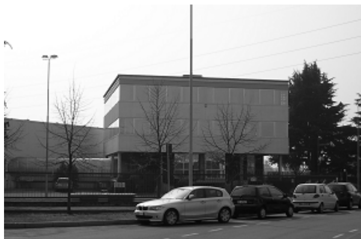
Figura 78 Ditta ELESA Via Pompei
