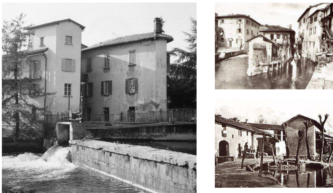
Figura 92 I mulini sull'isolino nel centro, situato a cavallo di una diramazione del Lambro ora coperta dallo spalto S.ta Maddalena
