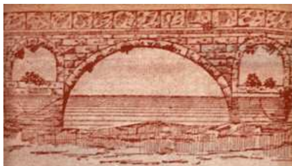
Figura 63 Il Ponte di Arena
