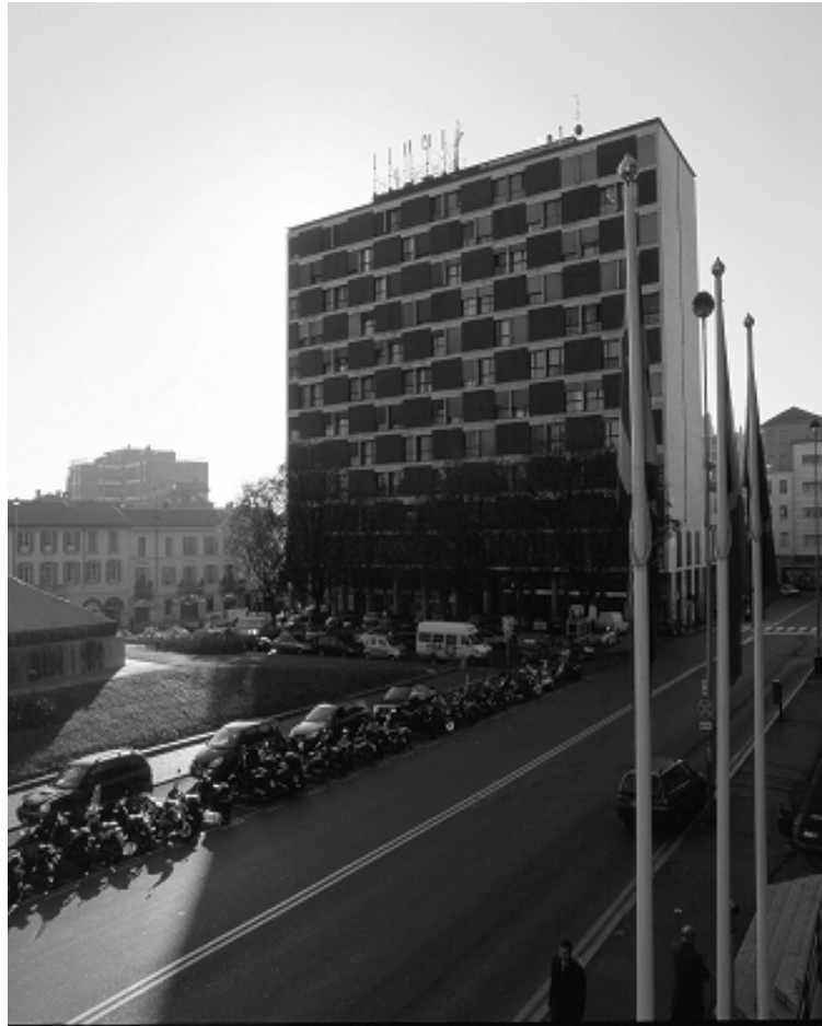
Figura 82 Palazzo Monza centro - Ingegnere Architetto Vittorio Faglia
